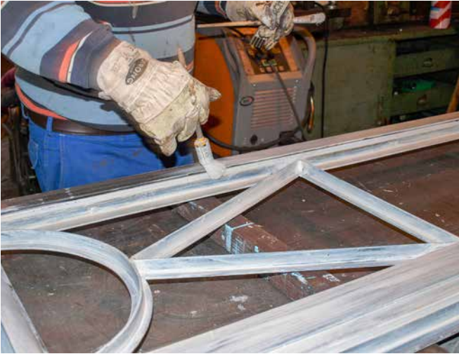
Fenstertür aus der „Grotte im Neuen Garten“ in Arbeit.
